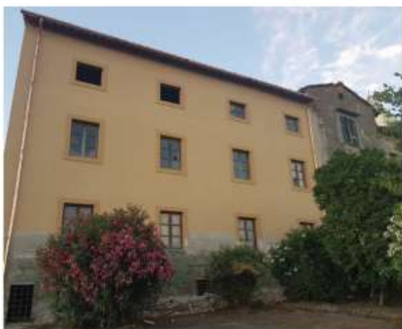
Montopoli in Val d'Arno, interventi alle coperture e alle facciate del Conservatorio Santa Marta.
